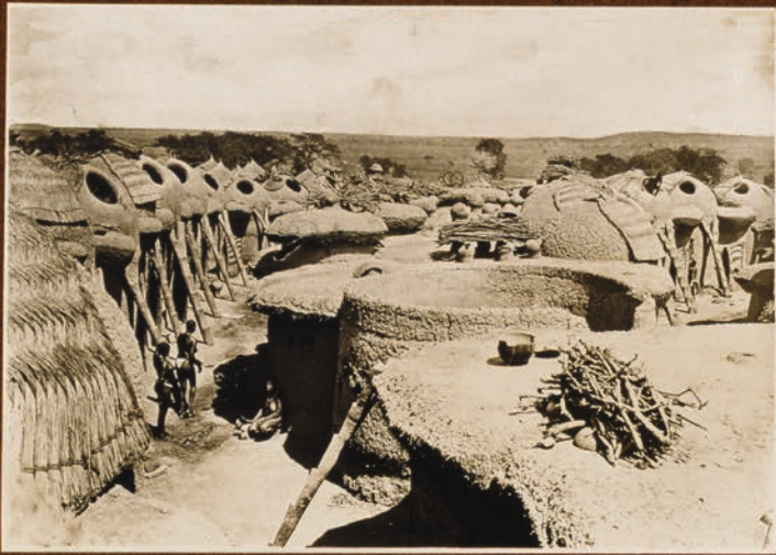
Vue intérieure d'un tala
